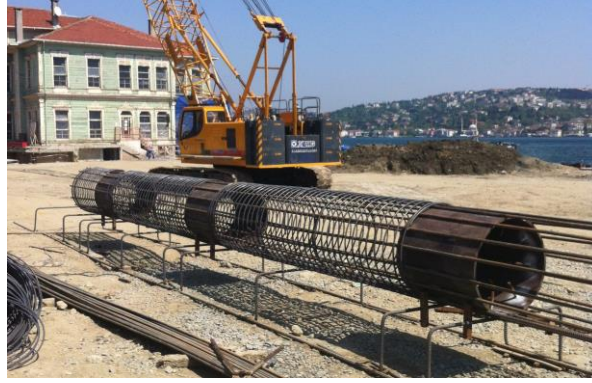
Şekil 9. İlave Fore Kazık Bağlantı Demiri- Ring Plaka Uygulaması
