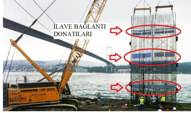
Şekil 7. Döşeme ve Temel Seviyelerine Yerleştirilen İlave Bağlantı Donatıları
