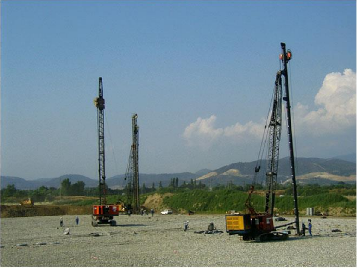
Bursa Atıksu Arıtma Tesisi Önyükleme ve Düşey Prefabrike Dren ile Zemin Islahı
