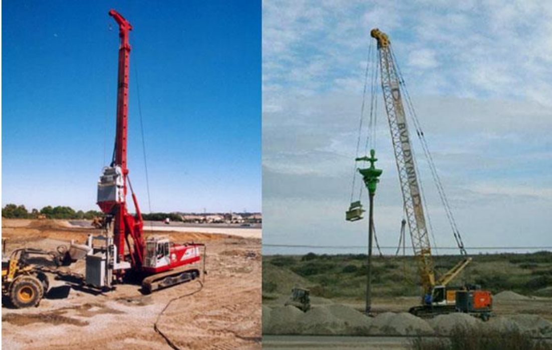
Kuru tabandan beslemeli taş kolon uygulaması
